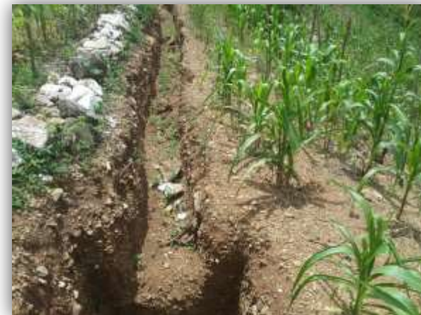
Acequias unidas a pozo de infiltración
