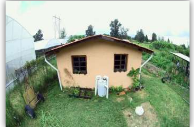
Sistema de captación de agua de lluvia
