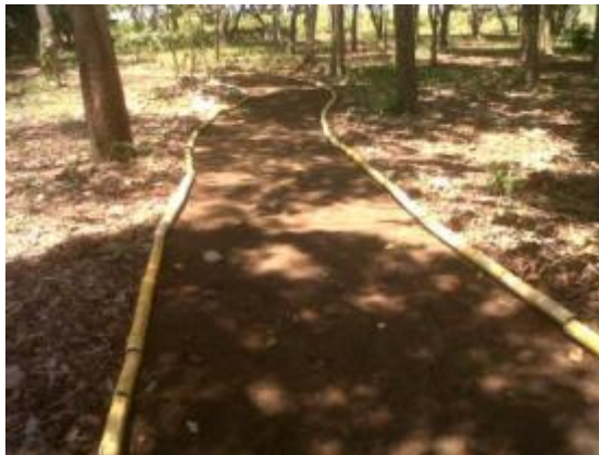
Figura 3. 41. Disposición de sendero con bambú
