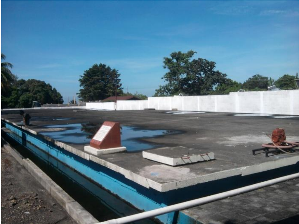
Figura 20. Tanque del predio municipal.
