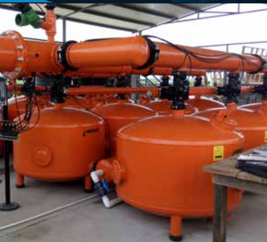
Figura 16. Infraestructura para filtrado del agua y fertirriego, Ingénio Pantaleón, Finca Puyumate
