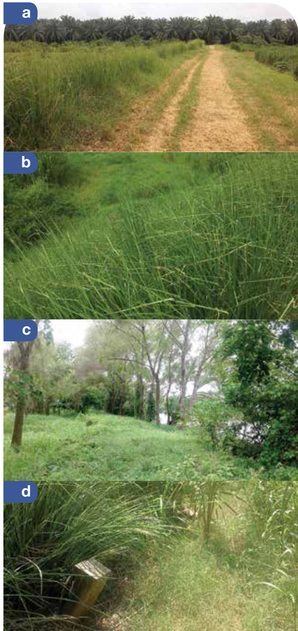
Figura 40. a y b) Dique Longitudinal en finca el Manantial, río Coyolate. c y d) Dique longitudinal con bioingeniería en aldea Santa Odilia, río Coyolate.
