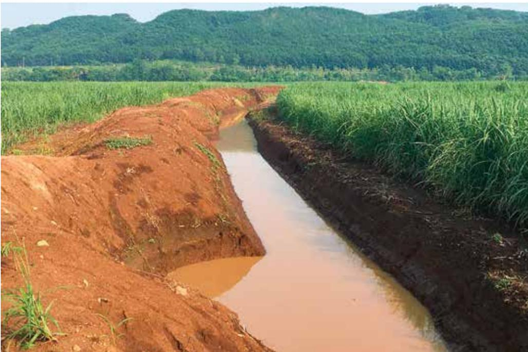
**Figura 51.** Acequia de ladera en combinación con pozos de infiltración como estructuras de conservación de suelo y agua, en áreas de producción de caña de azúcar.
