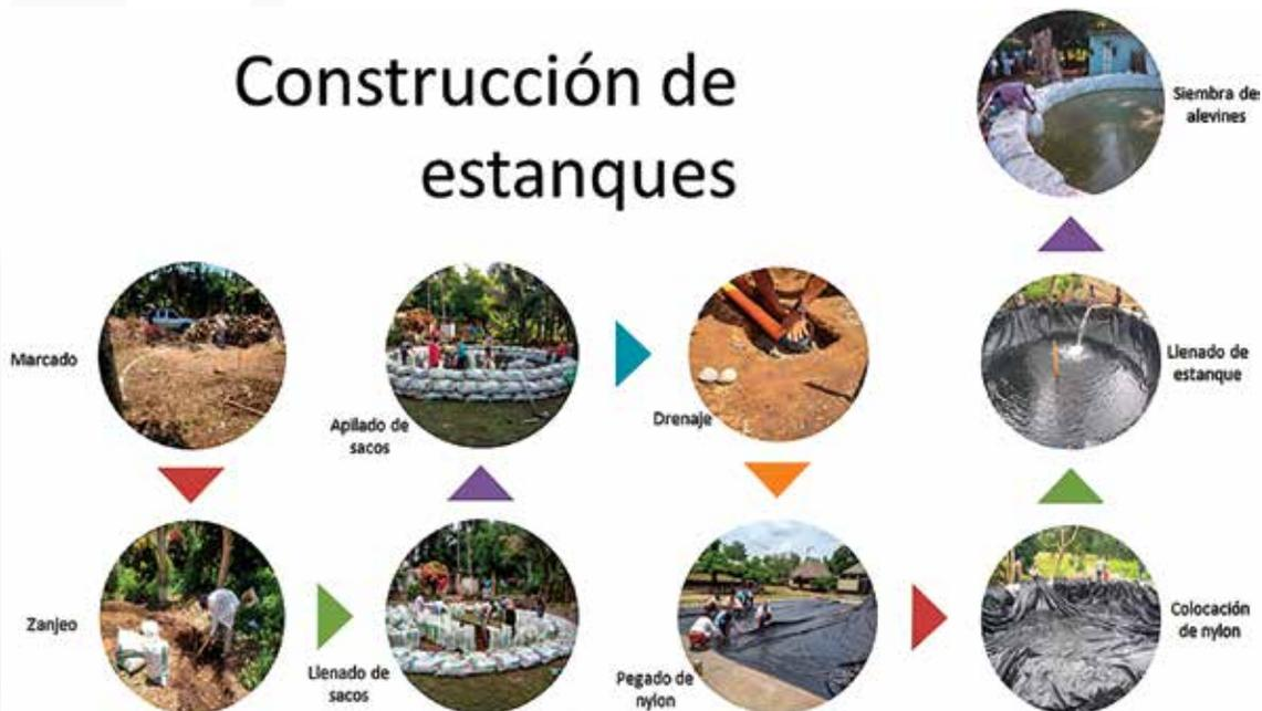
**Figura 64.** Proceso de la construcción de estanques.
