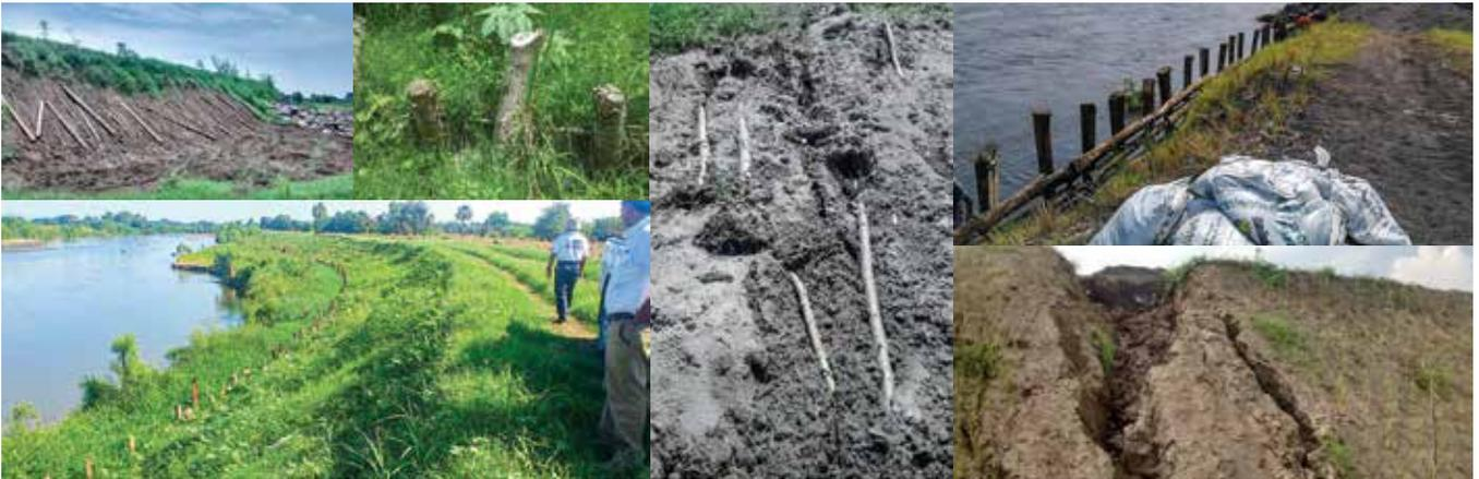
**Figura 80.** Diques longitudinales (bordas) con técnicas de bioingeniería. Imagen inferior derecha, daño en borda sin mantenimiento.
