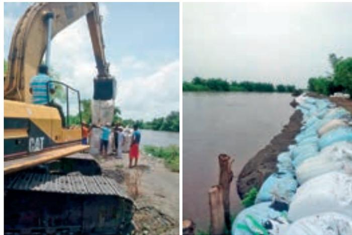
**Figura 110.** Apoyo con maquinaria y jumbos para trabajos correctivos durante emergencias.
