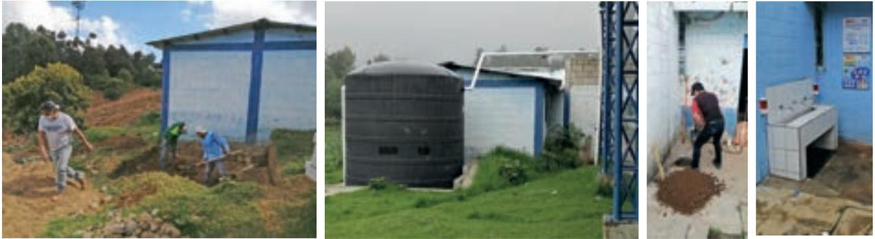
**Figura 31.** Construcción de sistemas de captación de agua de lluvia – SCALL en escuela Chichimuch, Sololá, Proyecto MACC-SAN.
