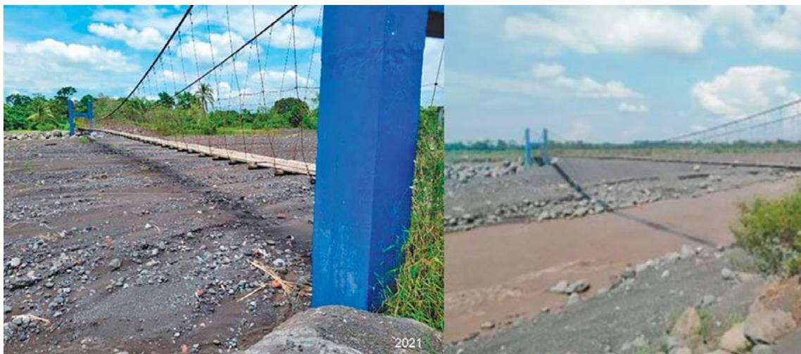
**Figura 77.** Azolvamiento del río Pantaleón durante el año 2021 y después de la intervención en el 2022.
