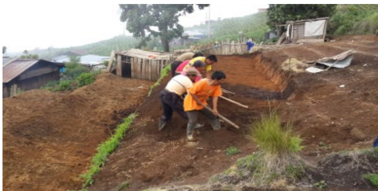
Figura 12. Construcción de terrazas en Nahualá, Sololá.
