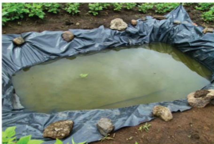
Figura 10. Captación de agua de lluvia con plástico.
